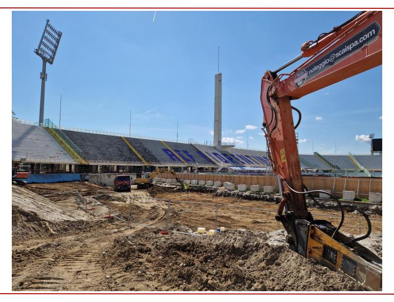
avanzamento lavori – set 24 - Scavi lato Curva Fiesole, propedeutici alla realizzazione delle nuove strutture
