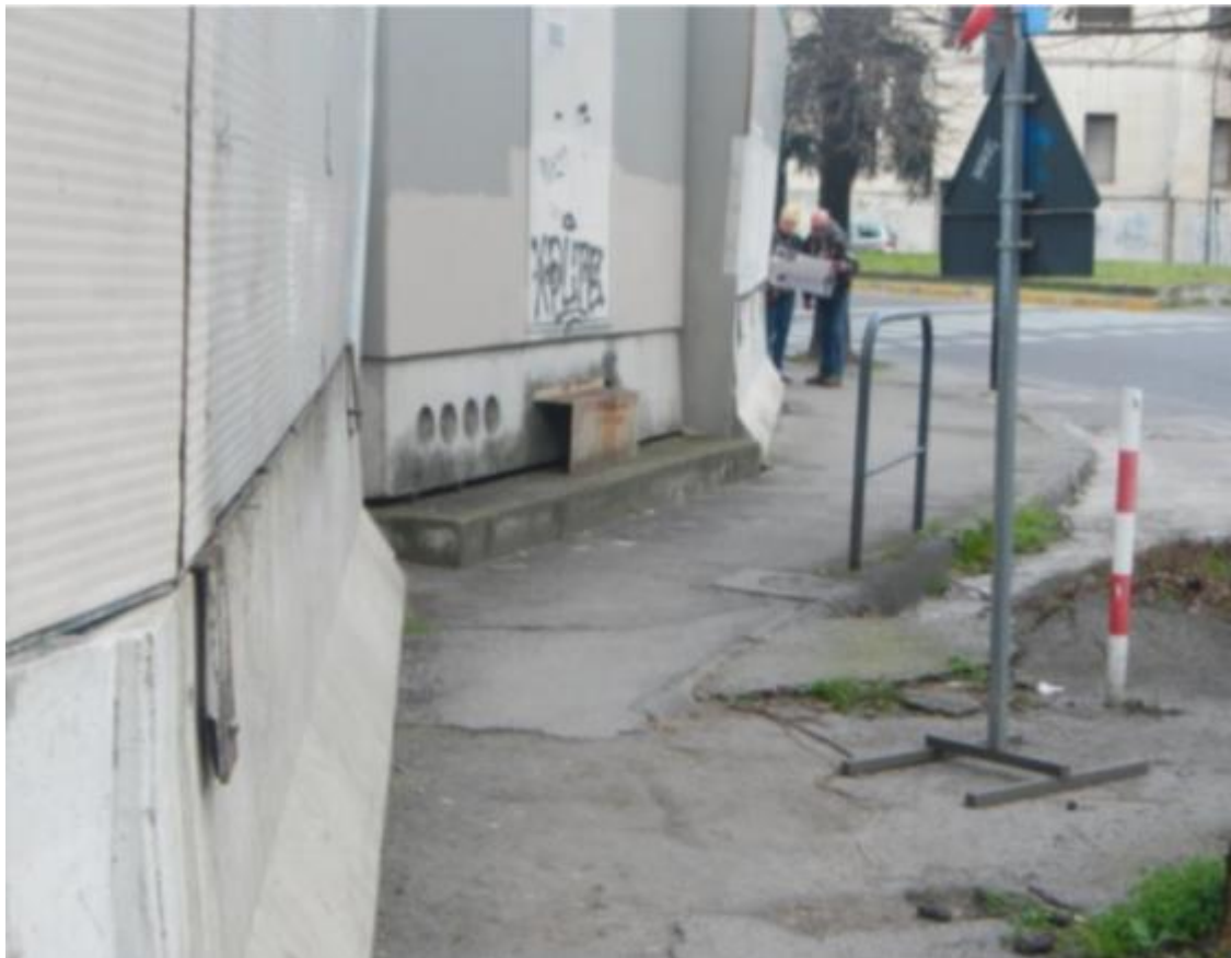
Termine della pista ciclabile – via Benedetto Marcello (FI)
