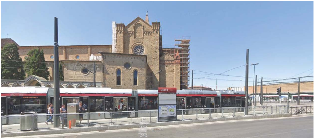
Piazza dell'Unità via degli avelli lato S.M. Novella Piazza Stazione
