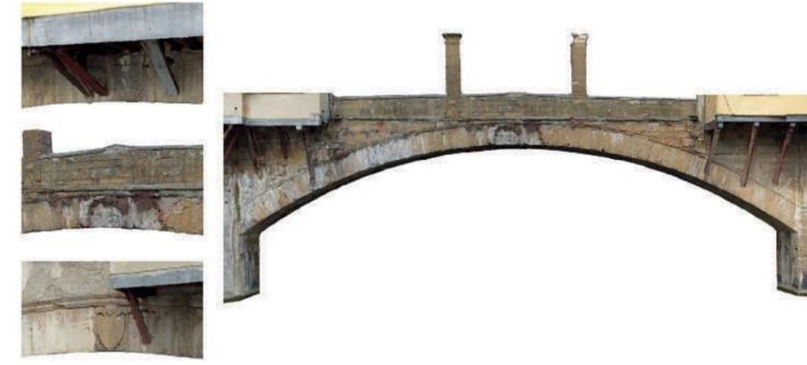
Dettagli del modello fotogrammetrico del prospetto est elaborato tramite tecniche SfM, dal quale sono state estratte viste altamente fotorealistiche e ortogonali con cui è stato sviluppato il fotopiano
