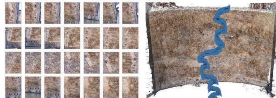
Sequenza fotografica di acquisizione necessaria per l'elaborazione di modelli fotogrammetrici dei paramenti delle sotto-arcate attraverso l'utilizzo di metodologie Structure from Motion (SfM)
