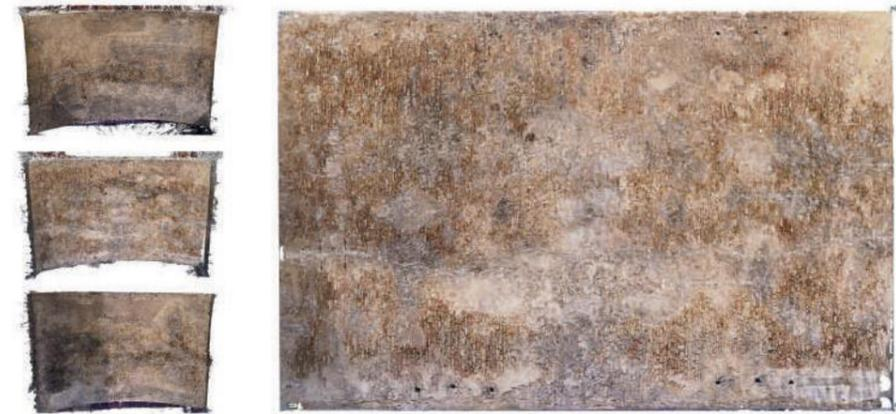
Elaborazione dei tre modelli fotogrammetrici SfM delle sotto-arcate dai quali sono state estratte viste altamente fotorealistiche e ortogonali con cui sono stati sviluppati i fotopiani, elaborati grafici necessari per lo svolgimento delle analisi diagnostiche
